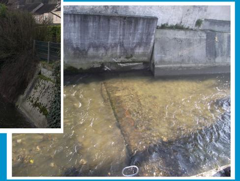
Ce clapet de régulation des inondations, bloqué en position haute, ne pouvait plus remplir sa fonction de régulation des crues. De plus, la Loi sur l'Eau et les Milieux Aquatiques instaure, entre autres, la réouverture des rivières aux poissons migrateurs. L'abaissement de ce clapet a permis de rendre la rivière accessible à tous les poissons pris d'envie de voyage.
